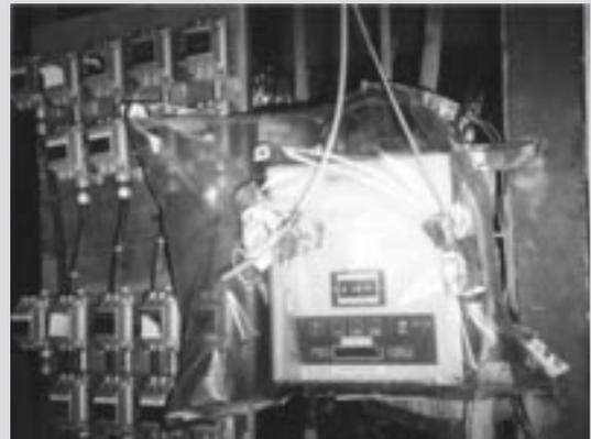
Panneau de contrôle électronique pressurisé au CO<sub>2</sub>
